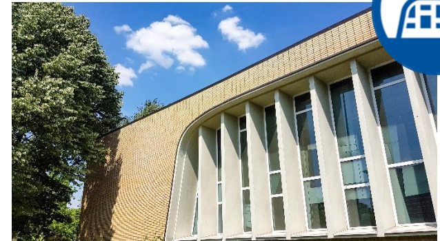
Außenfassade des Informatikzentrums
